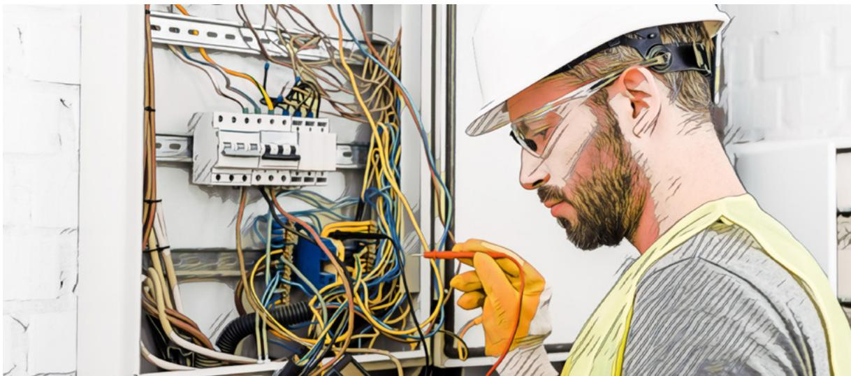
2 Se entiende por "instalaciones de enlace" en baja tensión aquellas que unen las cajas generales de protección, incluidas estas, con las instalaciones interiores o receptoras del usuario. Comenzarán en el final de la acometida y terminarán en los dispositivos generales de mando y protección.
